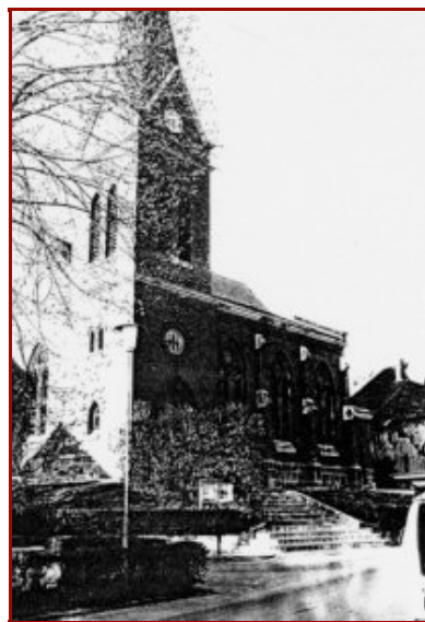
Рис. 52. В августе 1976 г. эта евангелическая церковь в D-96484 Меедере-Визенфельде была окурена Циклоном-Б. Впоследствии вся штукатурка покрылась синими пятнами (ср. рис. 53).
